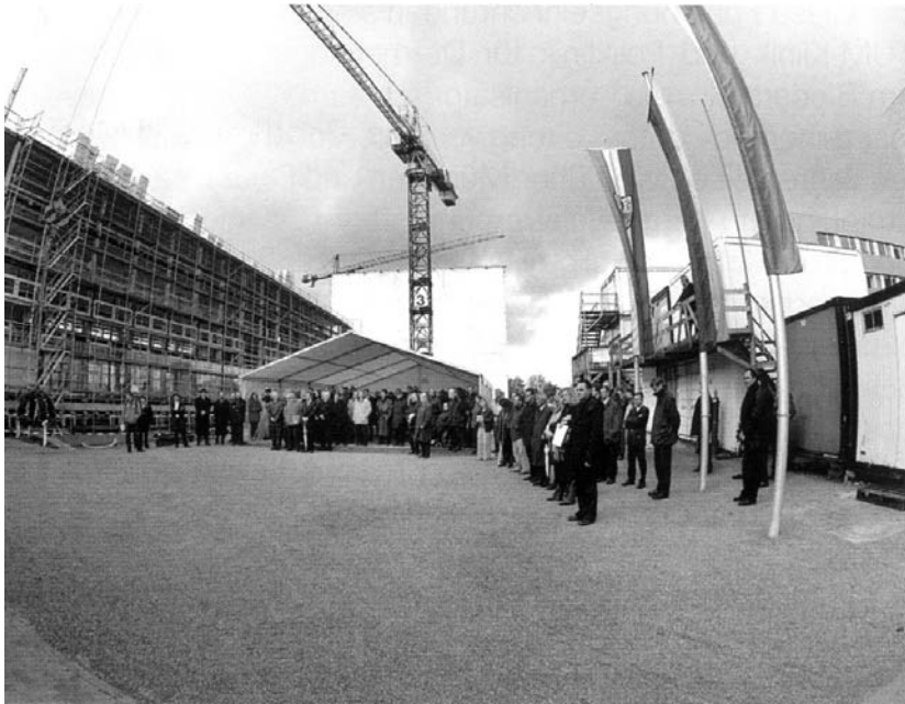
Richtfest LRZ in Garching
