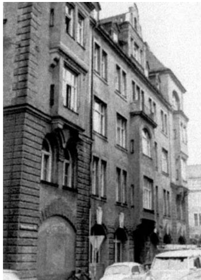
LRZ im Gebäude Richard-Wagner-Straße 18
